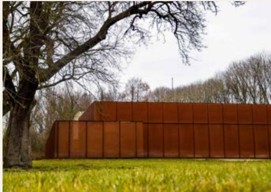
3.42 & 3.43 Utrecht schakelstation met MD strekmetaal van corten.
