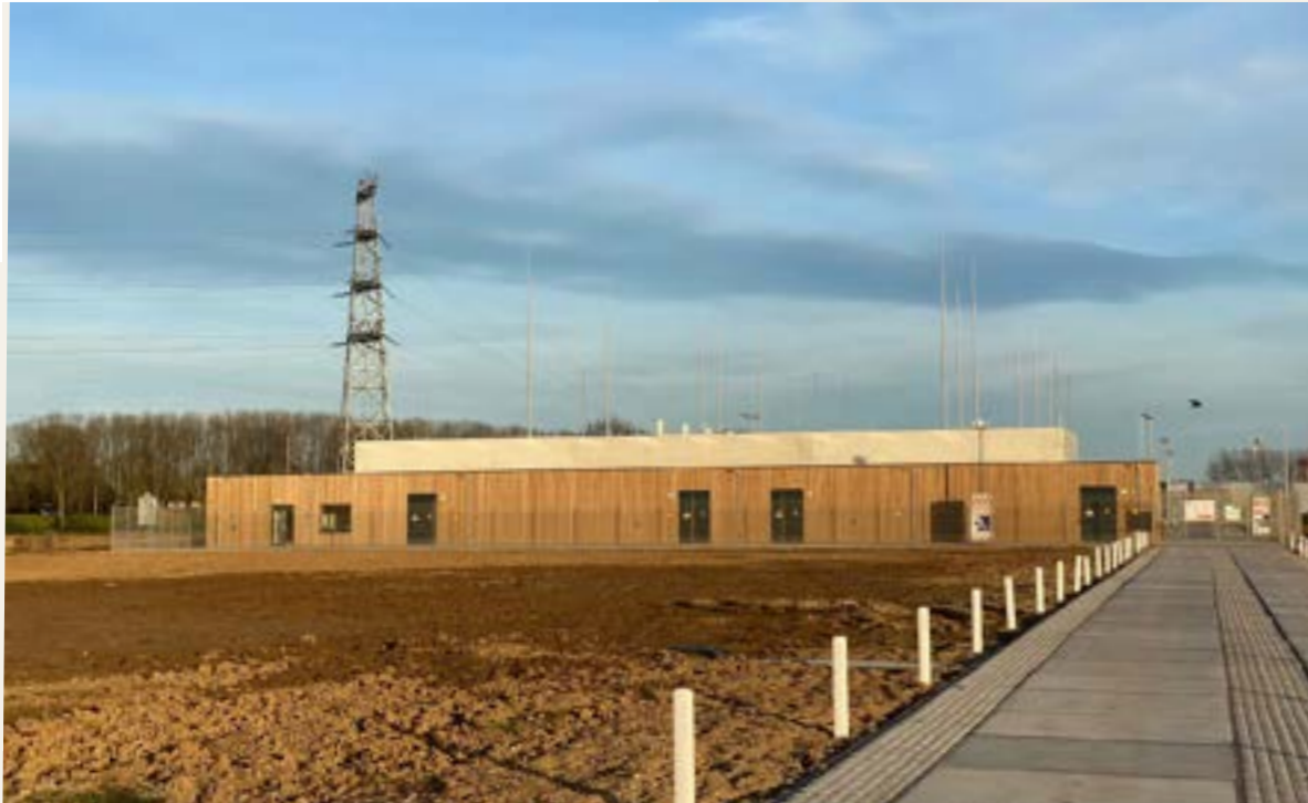
3.11 Voorbeeld station Oosterhout Nijmegen. Standaard modulair station.
