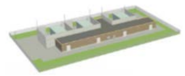
Onderstation 110/20 kV, 160 MVA (station maat: 20 x 59,3m) kavelmaat: 44 x 77,3m)
