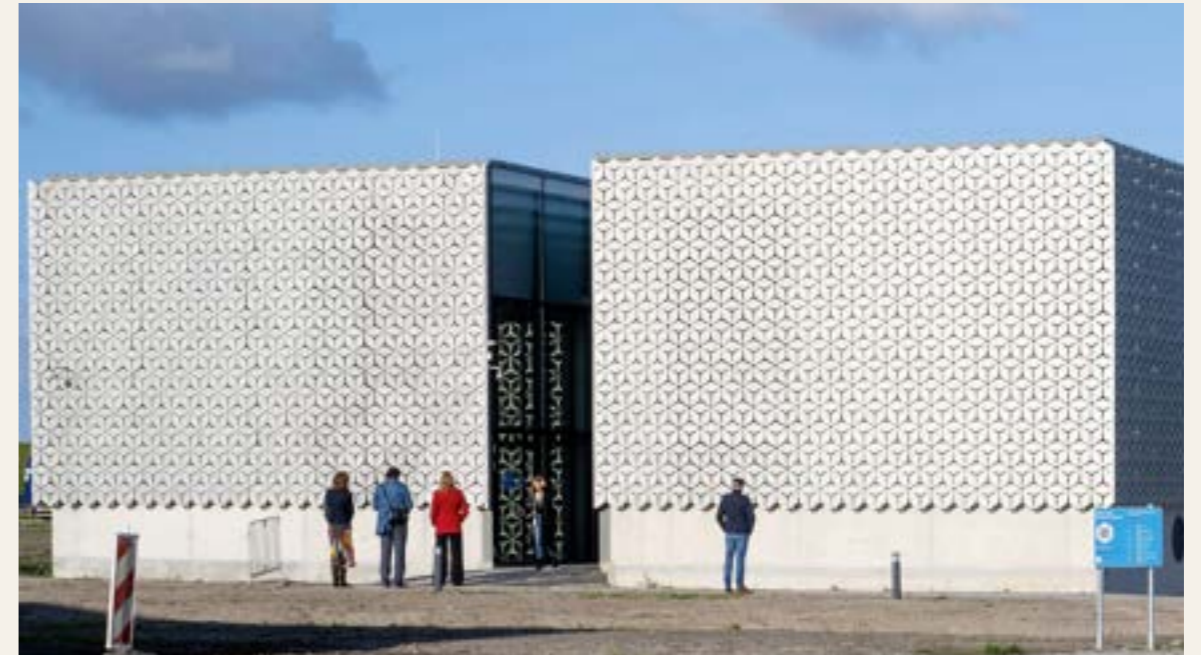
3.44 Windpark Fryslân transformatorstation met bewegende aluminiumplaatjes op de gevel.
