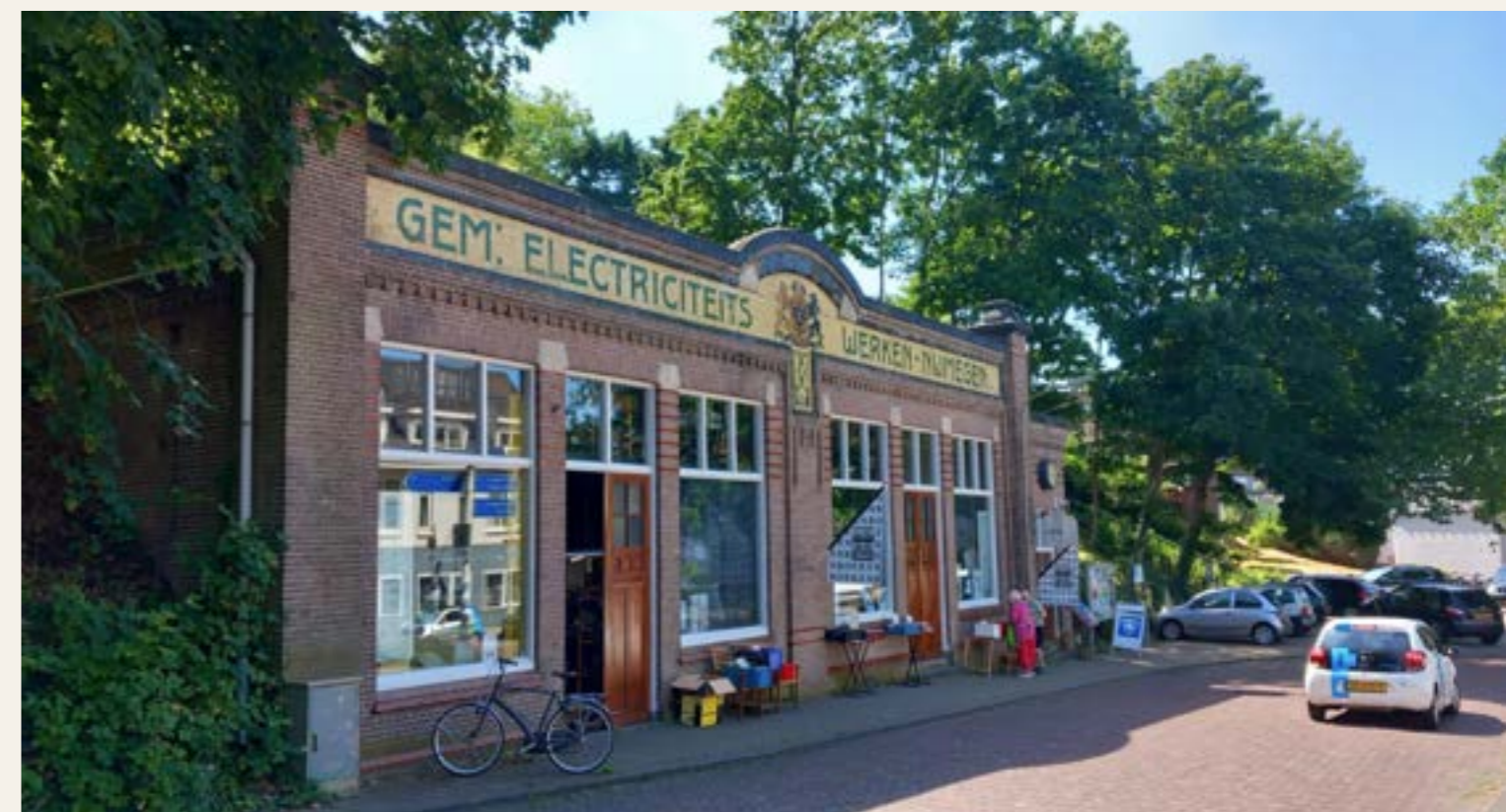
1.7 Voormalig station in gemeente Beek-Ubbergen.
