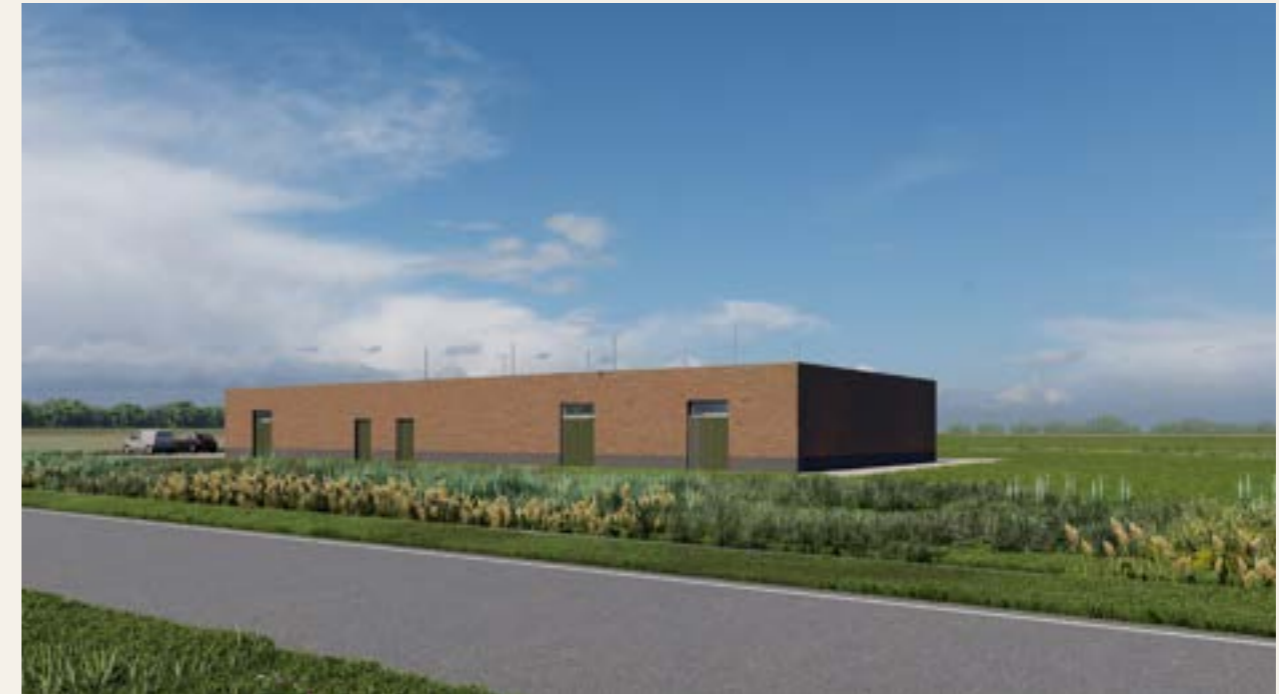
3.25 Voorbeeld station in open landschap Standaard modulair onderstation.
